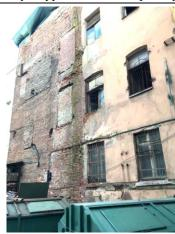
Фото 5. Дворовая территория. Состояние фасада здания со двора: кирпичная кладка оконных поемов, трещины, зазоры в стенах
