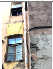
Фото 6. Состояние фасада здания со двора: трещины в стенах, отпадение штукатурного слоя
