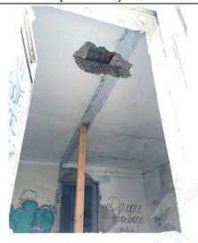
Фото 12. Типовое состояние внутренней отделки помещений 1 этажа: отпадение штукатурки, отслоение и отставание окрасочного слоя, сырые пятна, временные подпорки перекрытий
